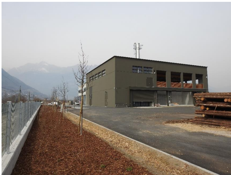
centrale di Merano Sud
