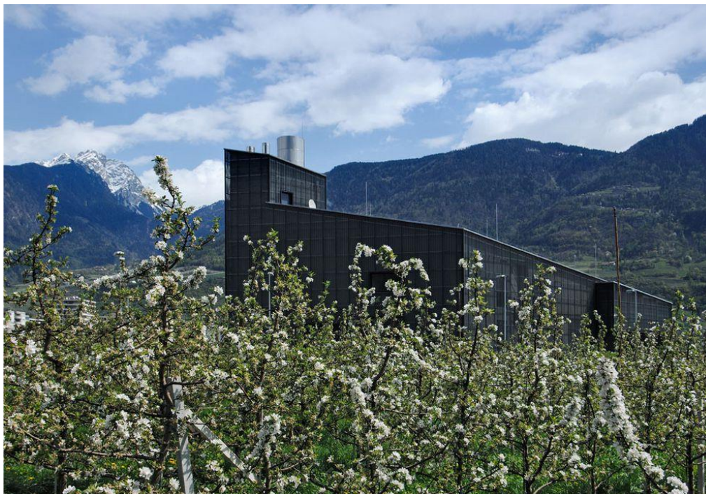
Centrale di Maia Bassa
