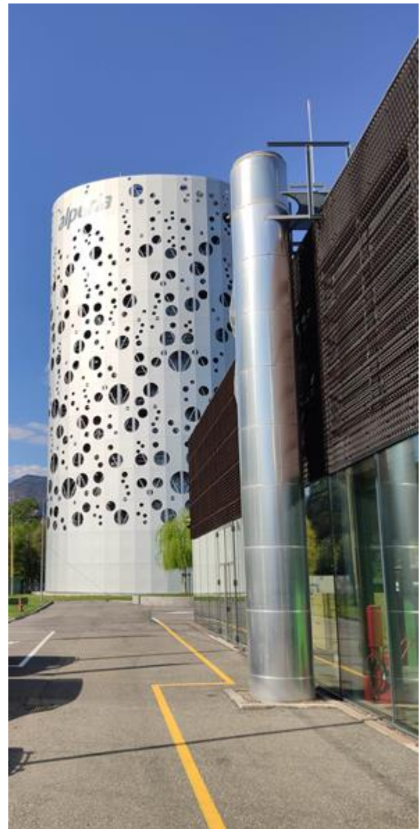
Centrale di Bolzano
